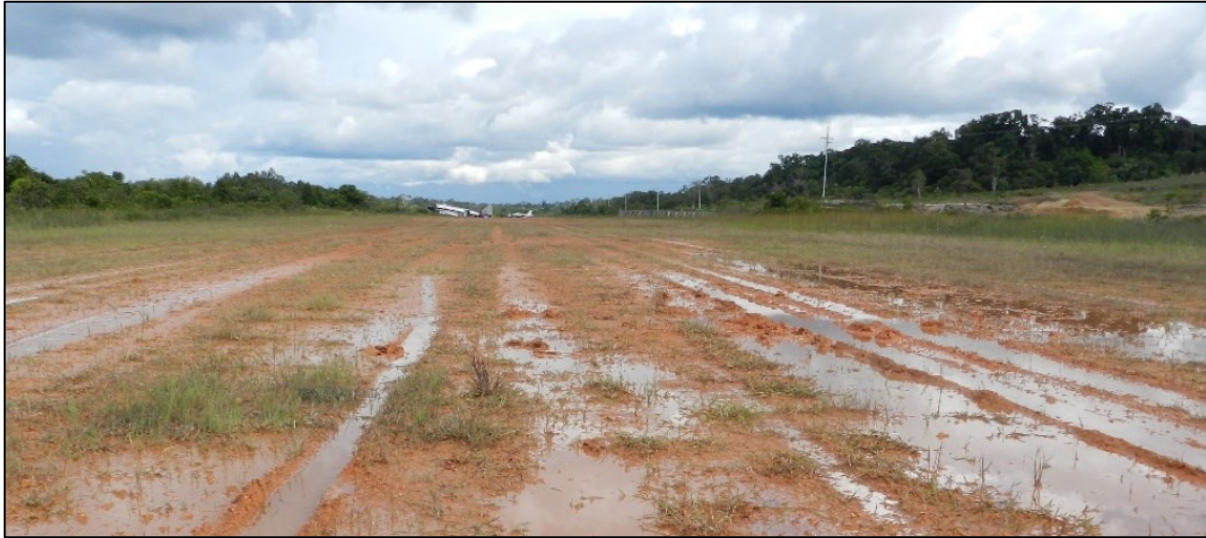
Fotografía N. 2 – Condición de la pista San Felipe (SKFP) en cabecera 18
